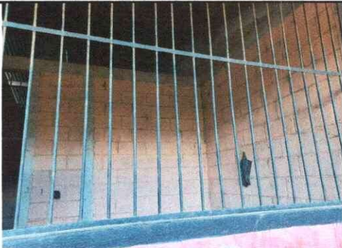
Foto 5: Se pueden observar uno de los balcones oxidados
